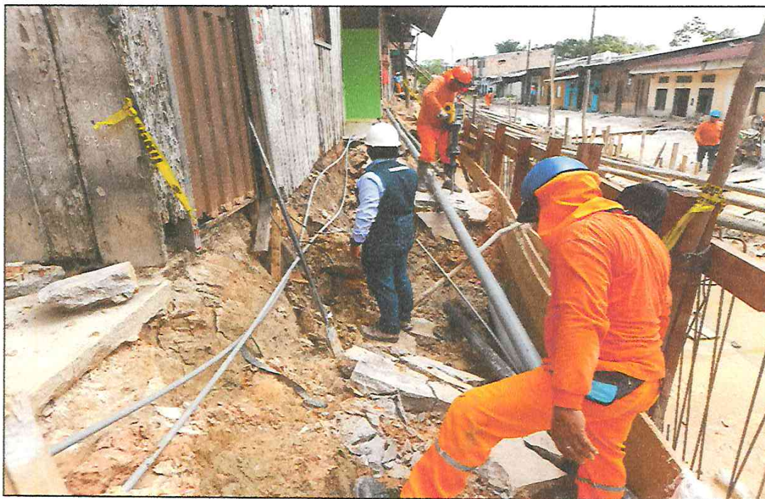
VISTA FOTOGRÁFICA N° 09: DEMOLICIÓN DE VEREDAS EXISTENTES DE MORTERO SIMPLE.
