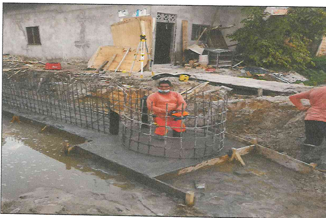
VISTA FOTOGRÁFICA N° 14: BUZÓN DE MORTERO ARMADO EN CALLE AMÉRICA TRAMO III.
